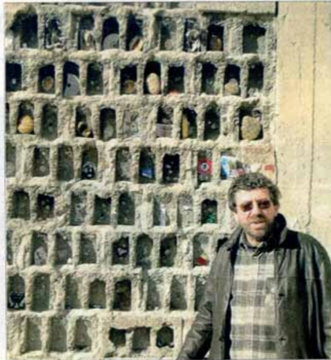
Michel Benoit, habitant du quartier, a créé un blog pour sauver le mur des offrandes qui devrait être démoli en raison de la construction de l'hôtel Marriott LE DL/Françoise DUMON
